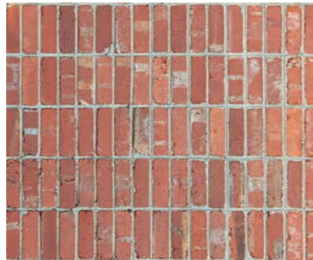
Indgangspartier belagt med rød tegl
