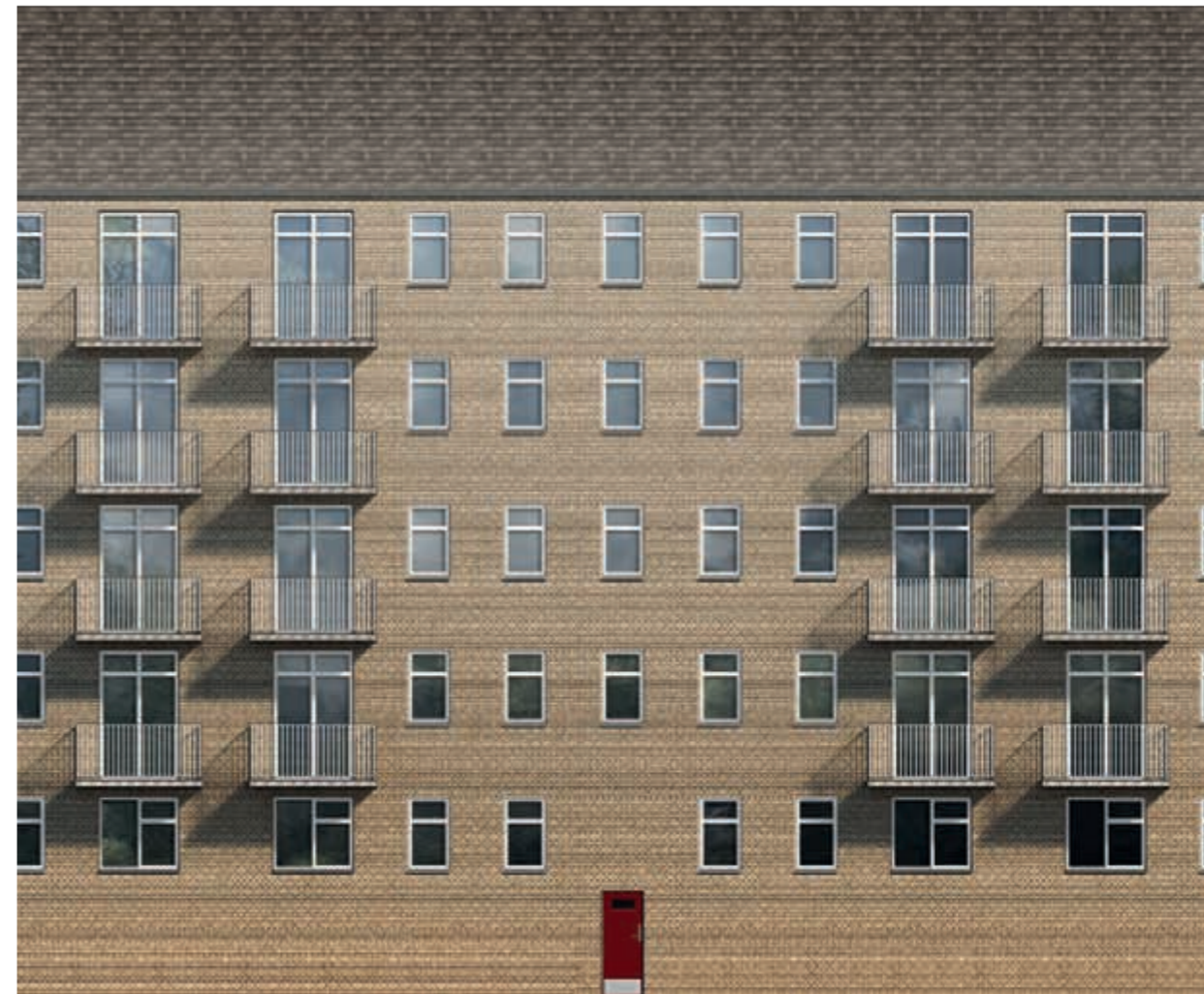
Udsnit af den noget mere beskedne vestlige inderside med stramme vinduesplacering og eftermonterede altaner.
