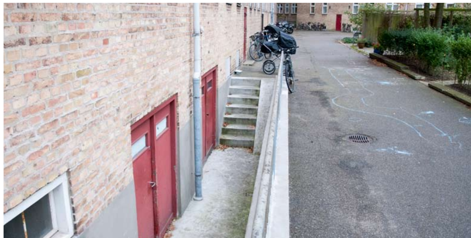
NEDGANG TIL CYKELKÆLDER - FØR
