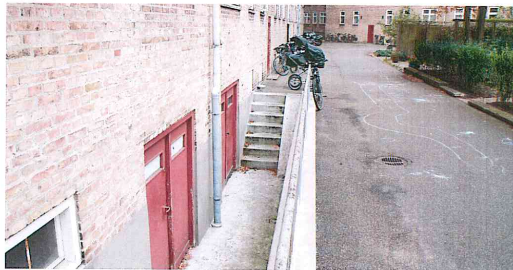
NEDGANG TIL KÆLDER - FØR
