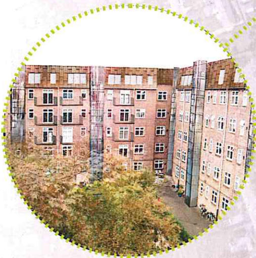
Forberinger i gårdmiljøet bl.a. med etablering af elevatorer til kælderplan
