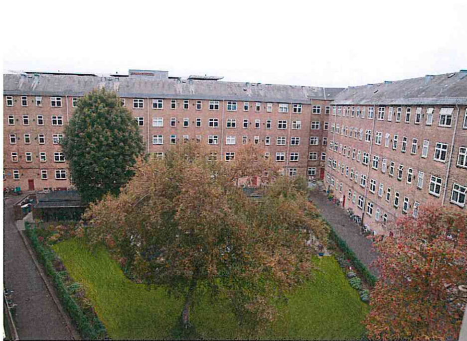
GÅRDRUM SET FRA ØVRE ETAGE - FØR OMBYGNING
