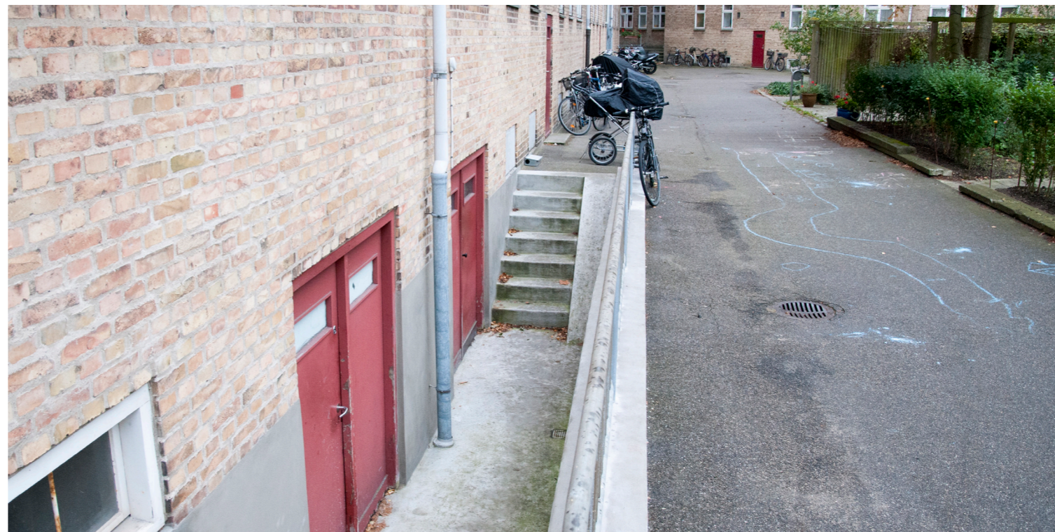
NEDGANG TIL CYKELKÆLDER - FØR
