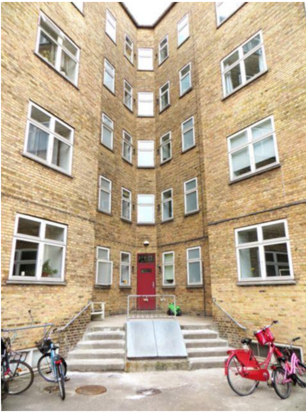
Kælderindgang i Nr. 71
